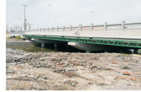
青浦区青昆路管线搬迁工程（市政供水）
