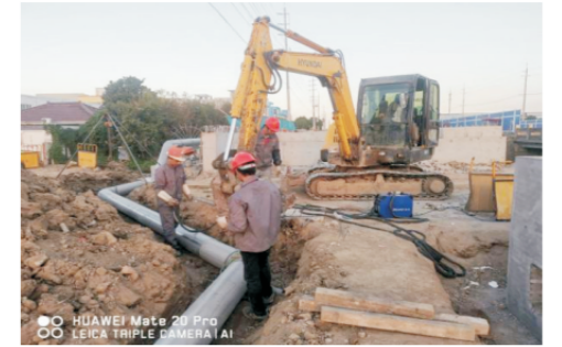
奉贤区—光河桥供水管网管道搬迁工程
