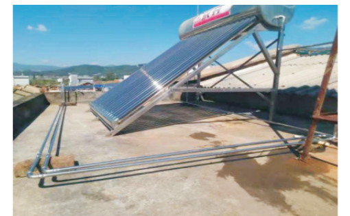
太阳能热水器管道安装工程
