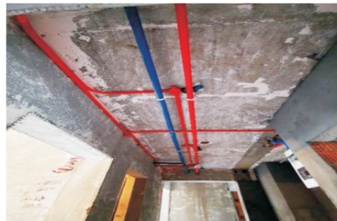
住宅楼小区饮水管道工程
