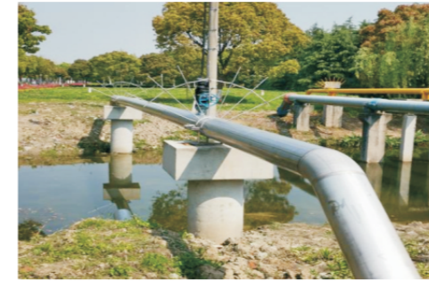
闵行区—徐联东路供水管线搬迁工程
