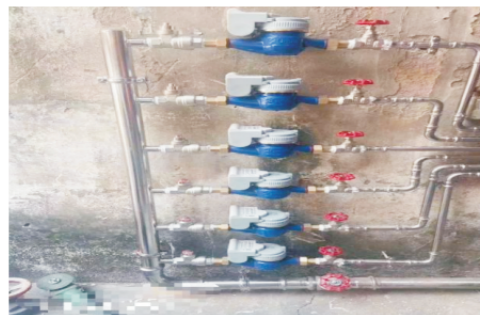
市政供水管网项目
