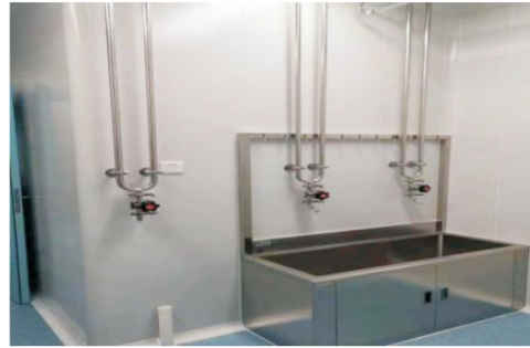
学校供水管道饮用水项目
