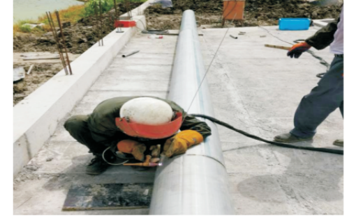
青浦区泖甸路供水管道桥管安装工程
