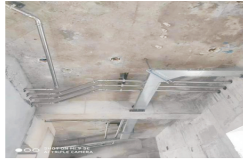
商务楼消防管道项目
